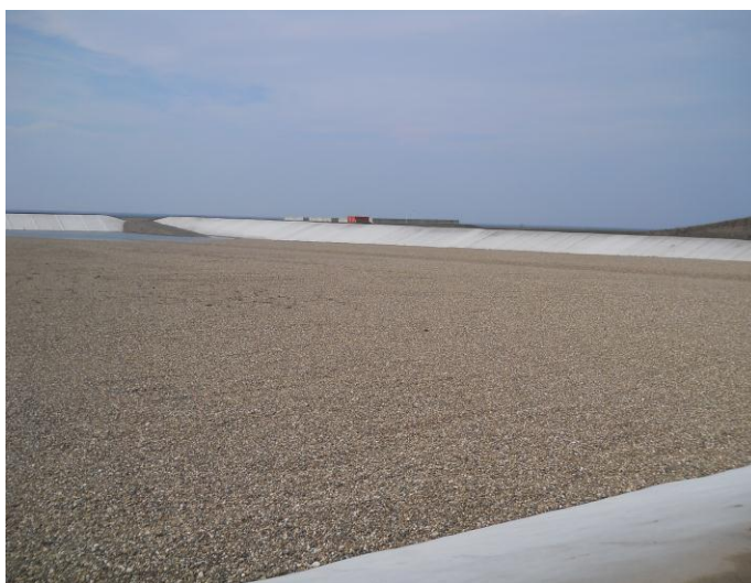
Depozitul de deșeuri industriale nepericuloase OMV Petrom
