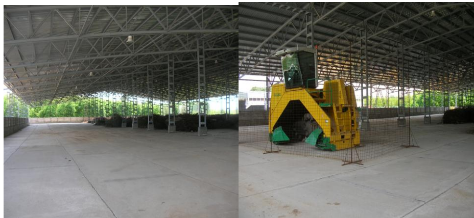
Stația de compostare Galați
