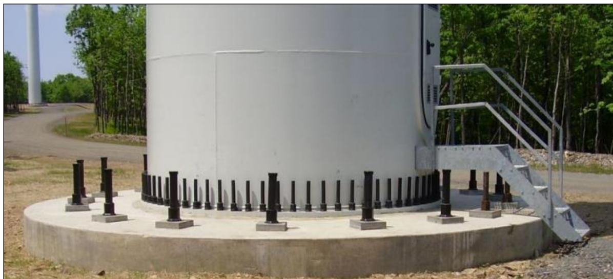
Figura 2-5: Ancorare turbina pe fundație
