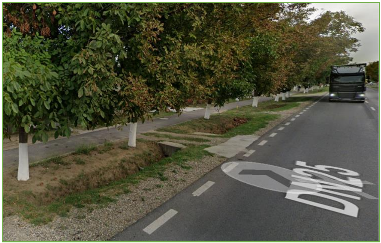
Figura 05. Prezentarea situației existente a șanțului de pe partea stângă a DN 25 din comuna Ivești, județul Galați
