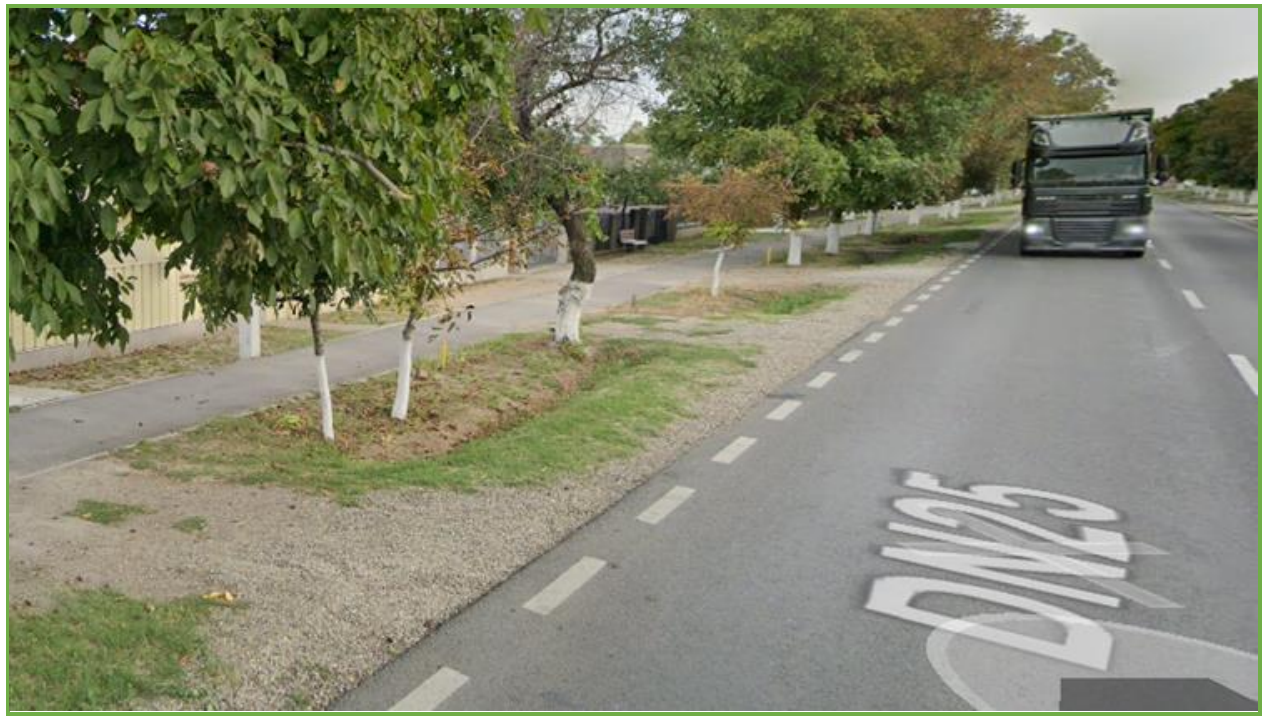
Figura 04. Prezentarea situației existente a șanțului de pe partea stângă a DN 25 din comuna Ivești, județul Galați
