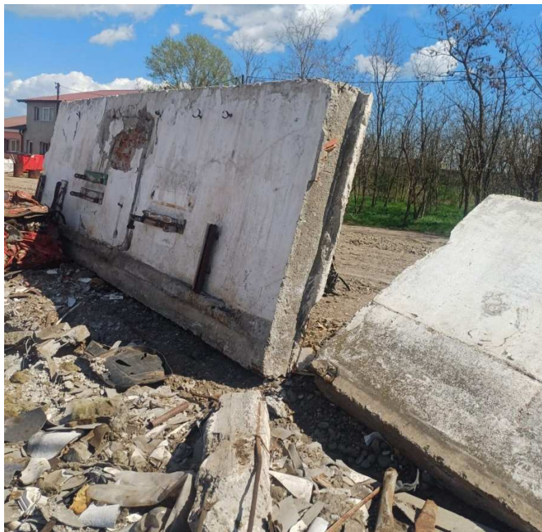
Figură 3: parapeți din beton care se vor utiliza pentru delimitarea amplasamentului și pentru realizarea compartimentării pentru depozitarea temporară a deșeurilor metalice
