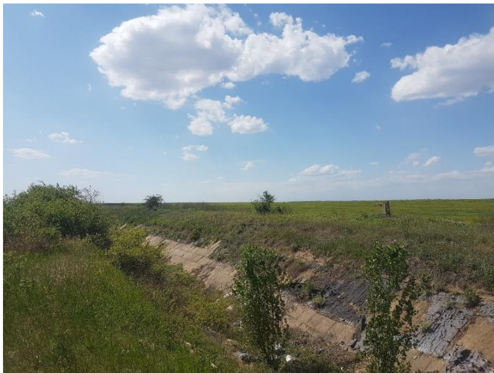
Foto 23: Fost canal de irigații în zona turbinei WTG3
