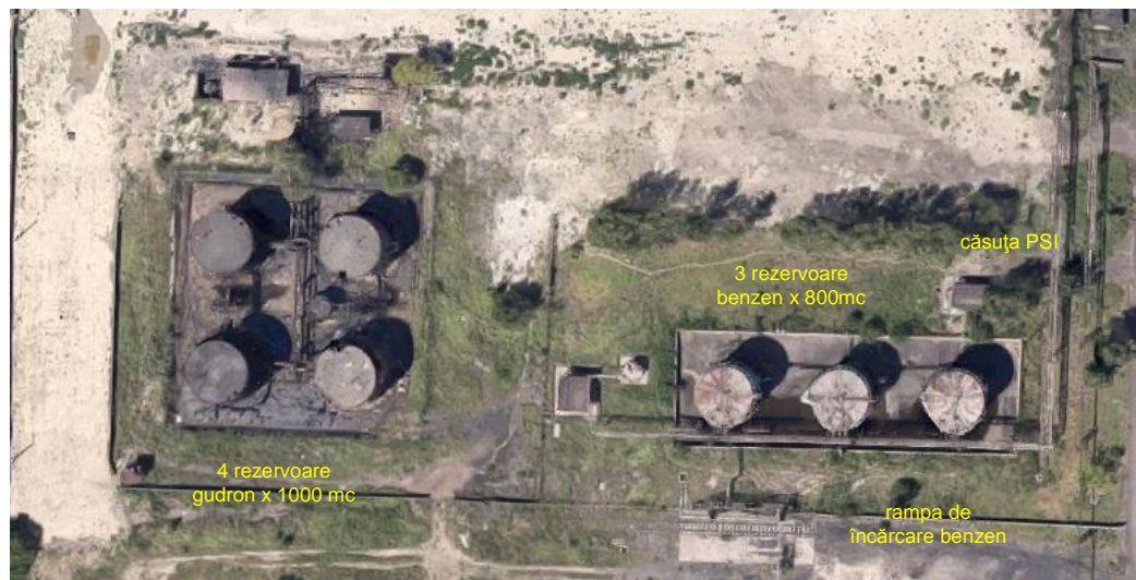
Depozitul II de benzen și gudron – Rampa de încărcare în cisterne CF
