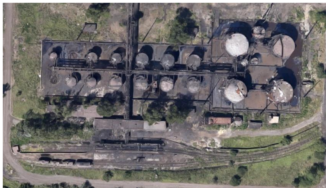
Depozitul Prelucrare gudron – Rampa de încărcare în cisterne CF
