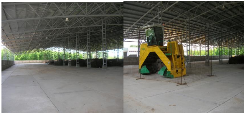
Stația de compostare Galați
