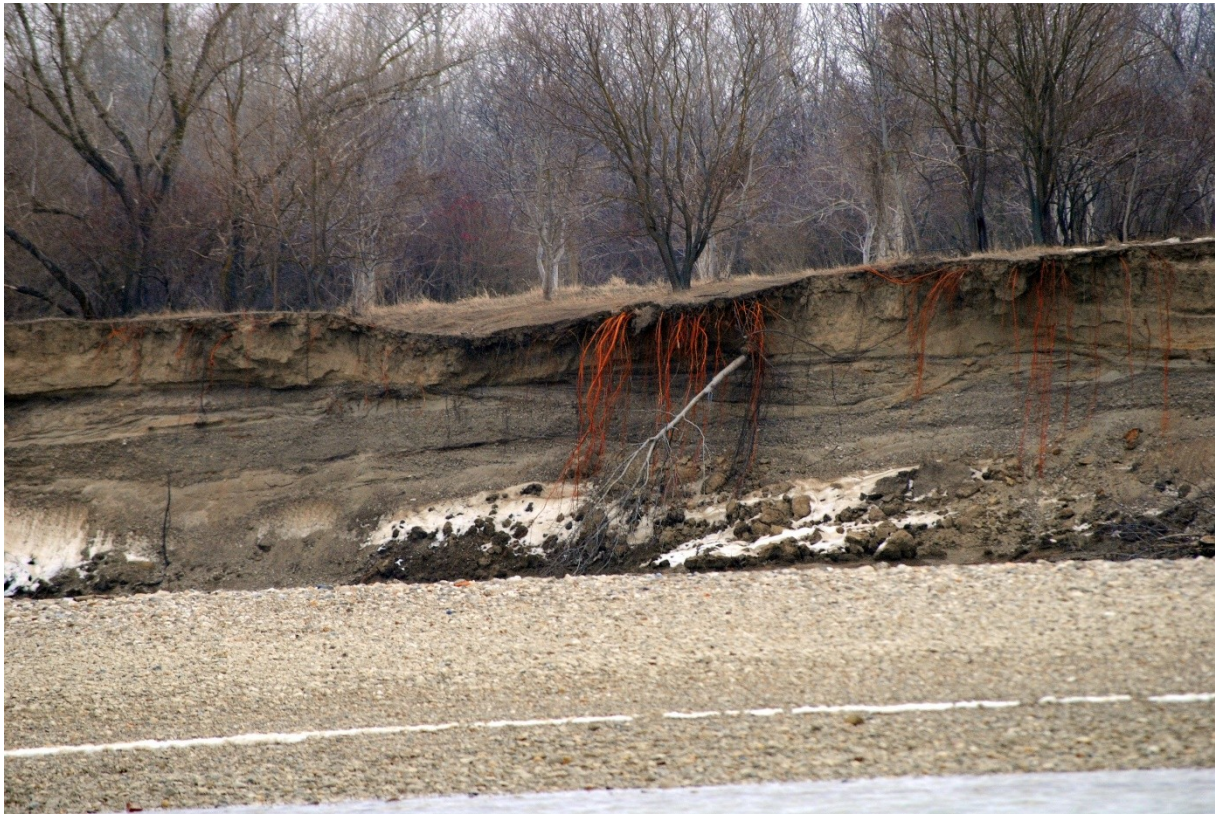
Figura nr. 1. Eroziunea activă a malului drept al râului Siret în zona analizată
