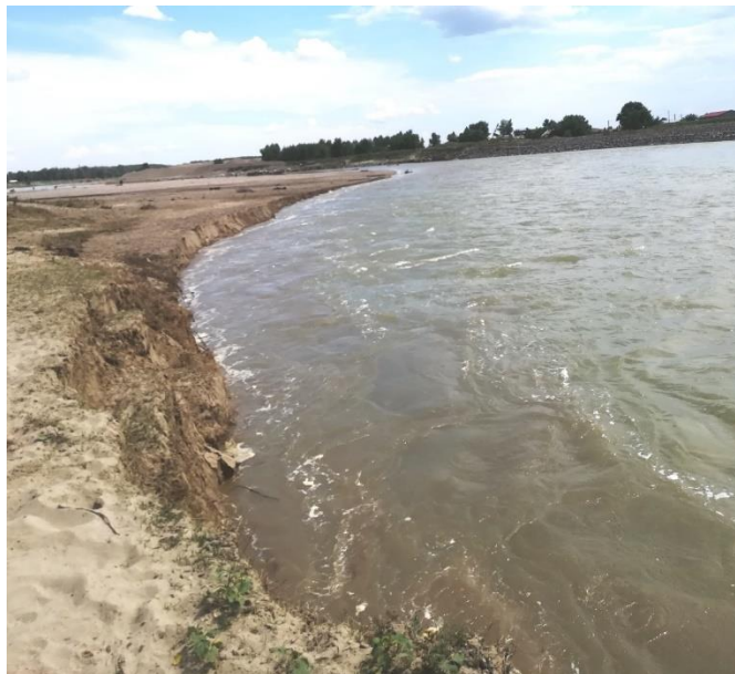
Fig. 3 Deviere curent principal către malul drept, de către depozitul Condrea Aval
