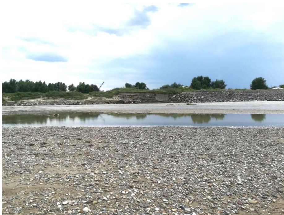
Fig. 4 Distrugerea apărării de mal în dreptul localității Suraia
