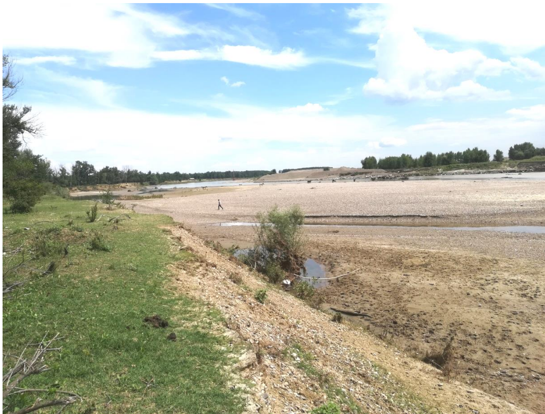
Fig. 7 Perimetrul Condrea aval văzut din amonte
