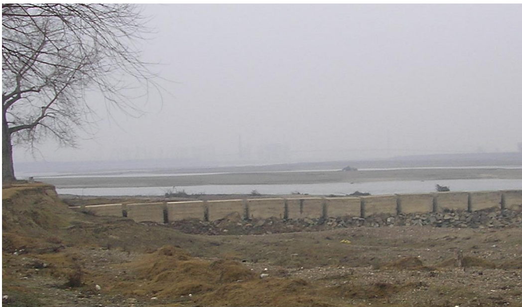
Fig 5 . E-piu din beton in capatul amonte al perimetrului S.C. Somaco Holding S.A.
