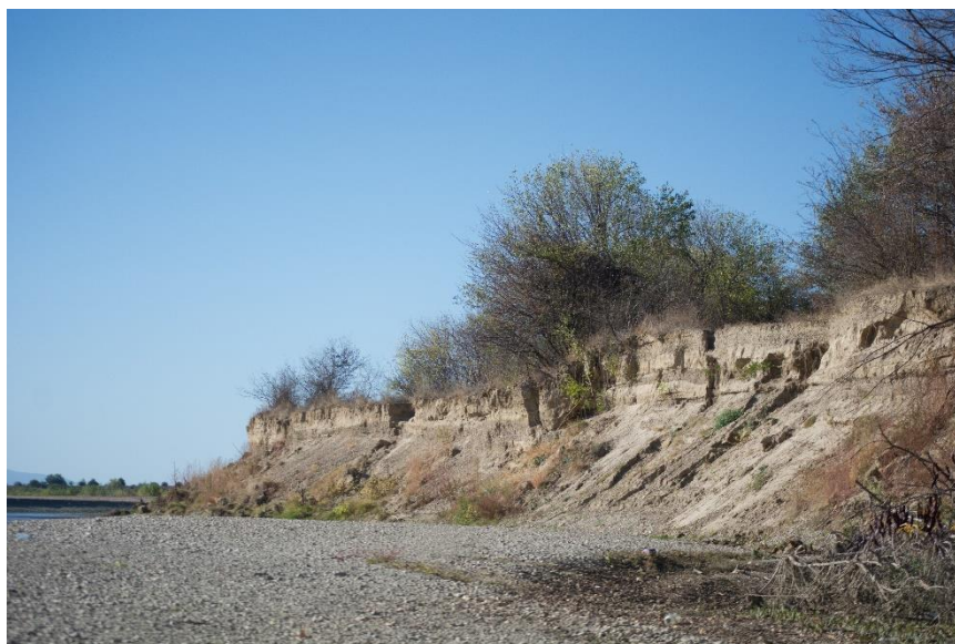
Fig. 59 Eroziune masivă în malul înalt din imediata vecinătate a zonei de interes a proiectului
