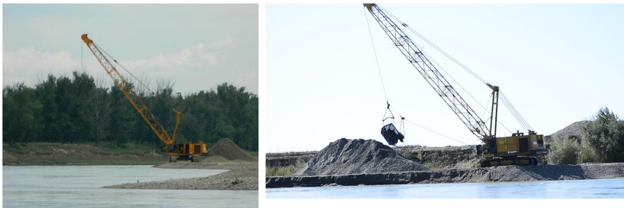
Fig. 66 Exploatarea agregatelor minerale direct din șenalul principal (exploatarea de pe malul drept în aval de perimetrul de interes, stg. iulie 2018, dreapta octombrie 2019)
