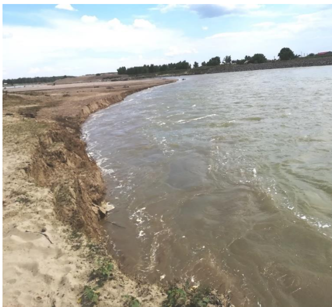
Fig. 67 Deviere curent principal către malul drept, de către depozitul Condrea Aval
