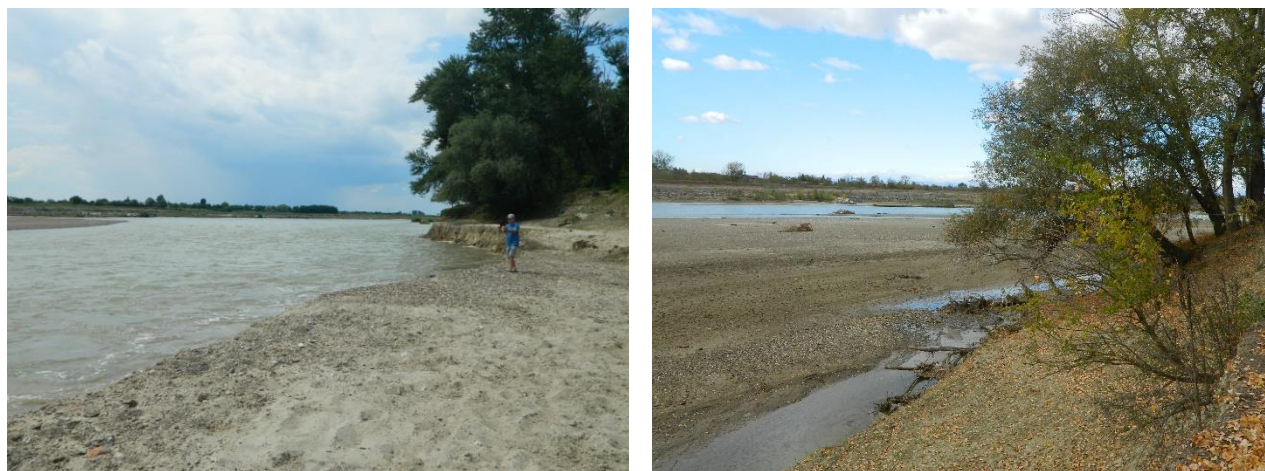
Fig. 6 Vedere în amonte dinspre zona de interes a proiectului cu surparea care afectează malul, iulie 2018 (stânga), respectiv octombrie 2018 (dreapta), cu depuneri masive de elemente minerale
