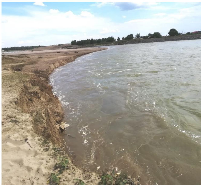
Fig. 27 Deviere curent principal către malul drept, de către depozitul Condrea Aval
