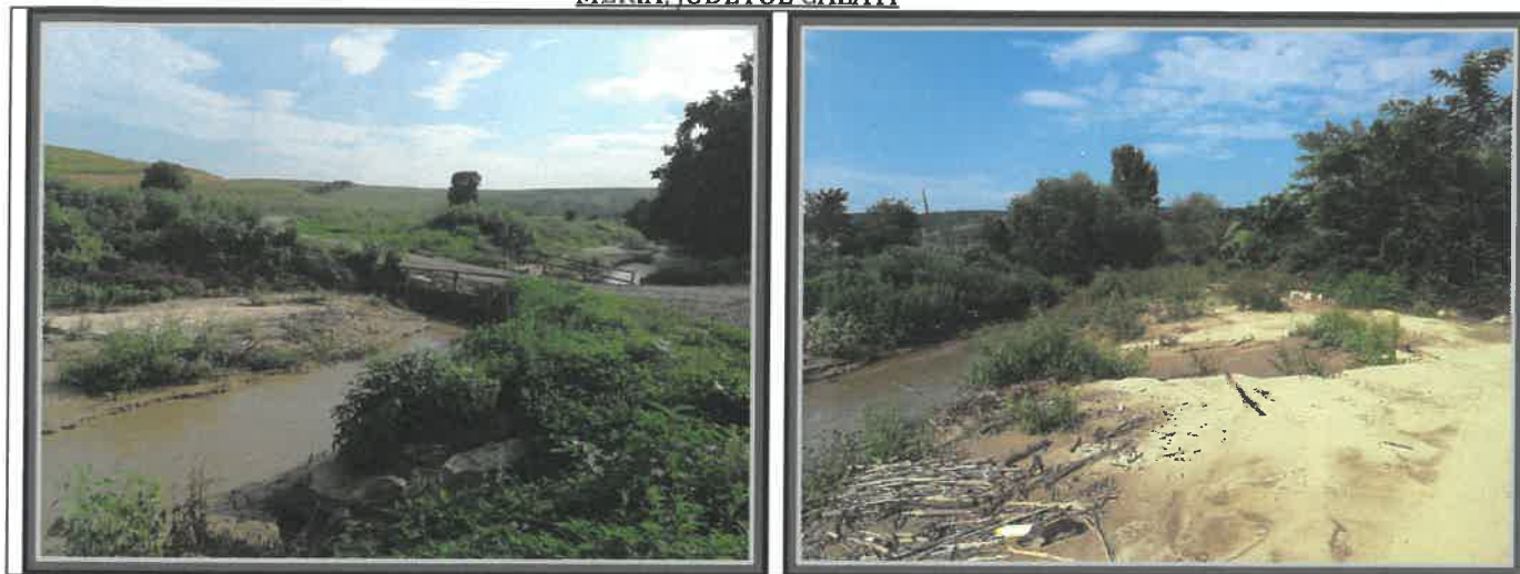
Figura 07. Prezentarea situatiei existente a podului peste torent in localitatea Aldesti - coordonatele geometrice ale amplasamentului proiectului, care vor fi prezentate su forma de vector in format digital cu referinta geografica, in sistem de proiectie nationala Stereo 1970
