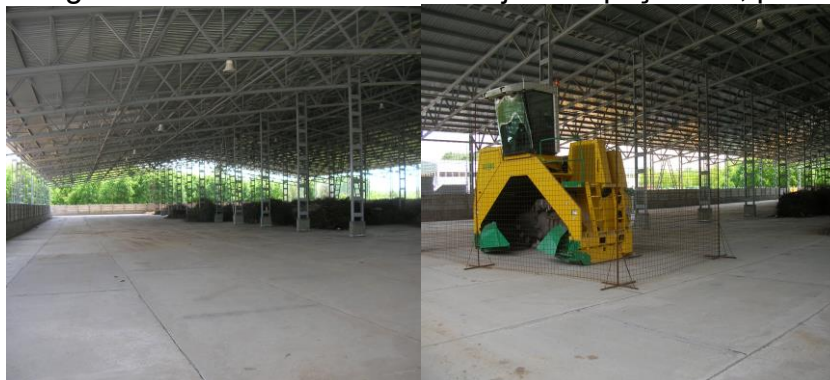
Stația de compostare Galați
