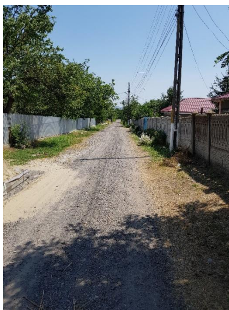
Fig.05 Prezentarea situației existente a drumului local D.L.5, sat Stoicani
