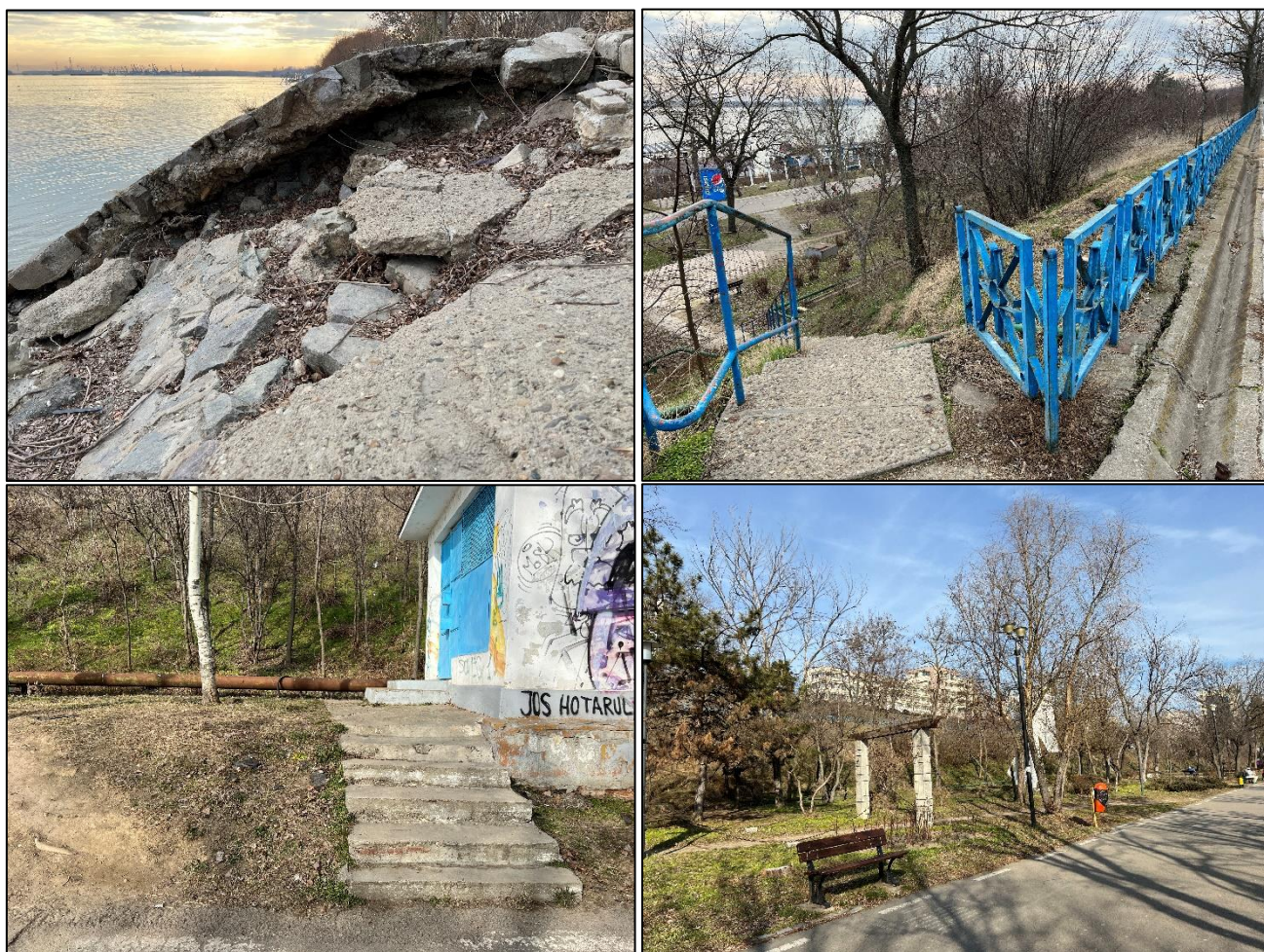
Fig. 24 Mobilier si elemente constructie- situatie existenta
