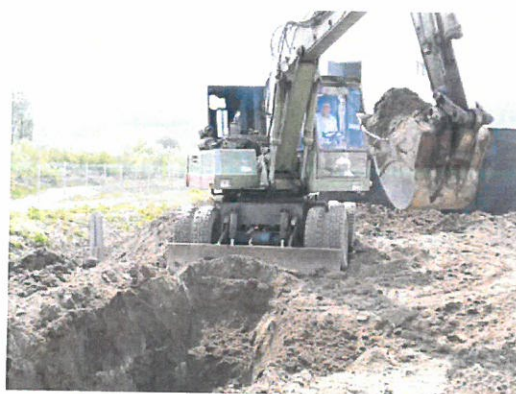
Fig. 1 Execuție groapa camin
