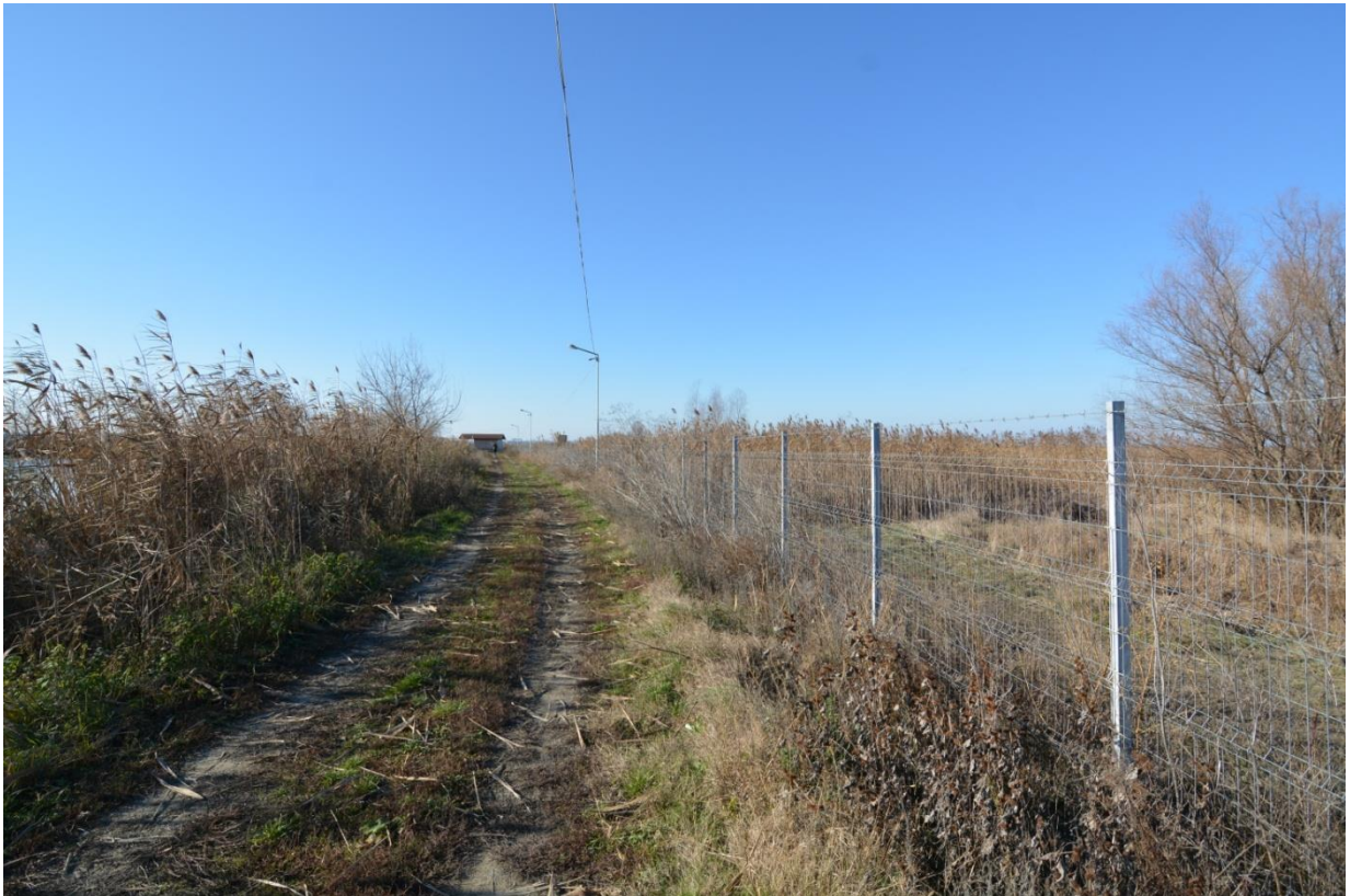
Foto nr. 5 – Tipologia gardului
