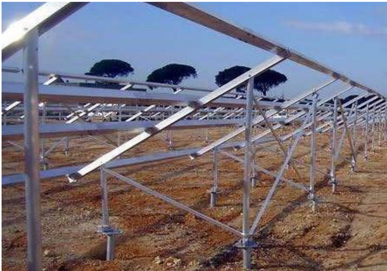
Fig.3.Fotografie informativa ale structurilor de susținere a instalației fotovoltaice.
