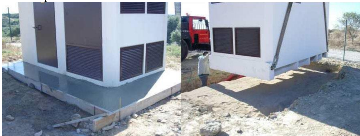
Fig.4. Fotografie informativa de poziționarea a transformatorului
