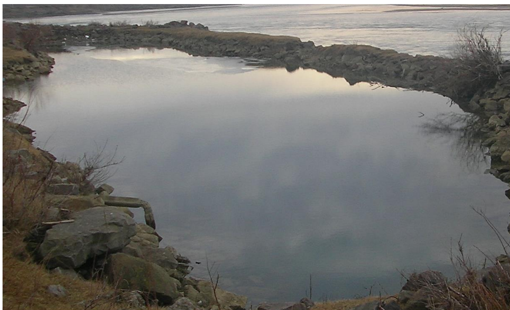
Fig 7 . Aparare de mal executata din blocuri de piatra lestate pe suluri de fascine
