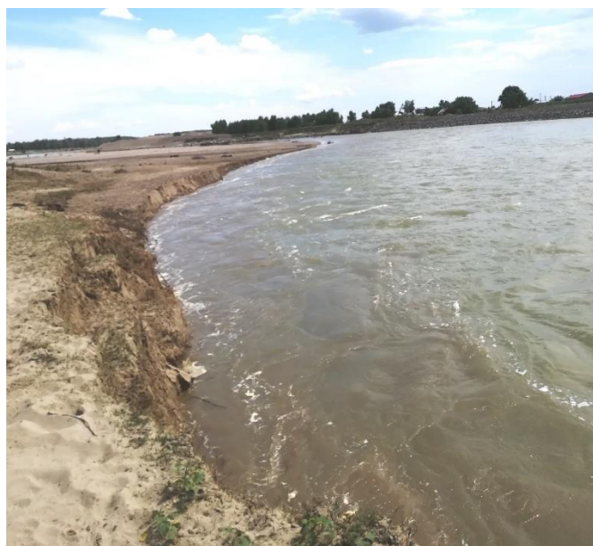
Fig. 4 Deviere curent principal către malul drept, de către depozitul Condrea Aval
