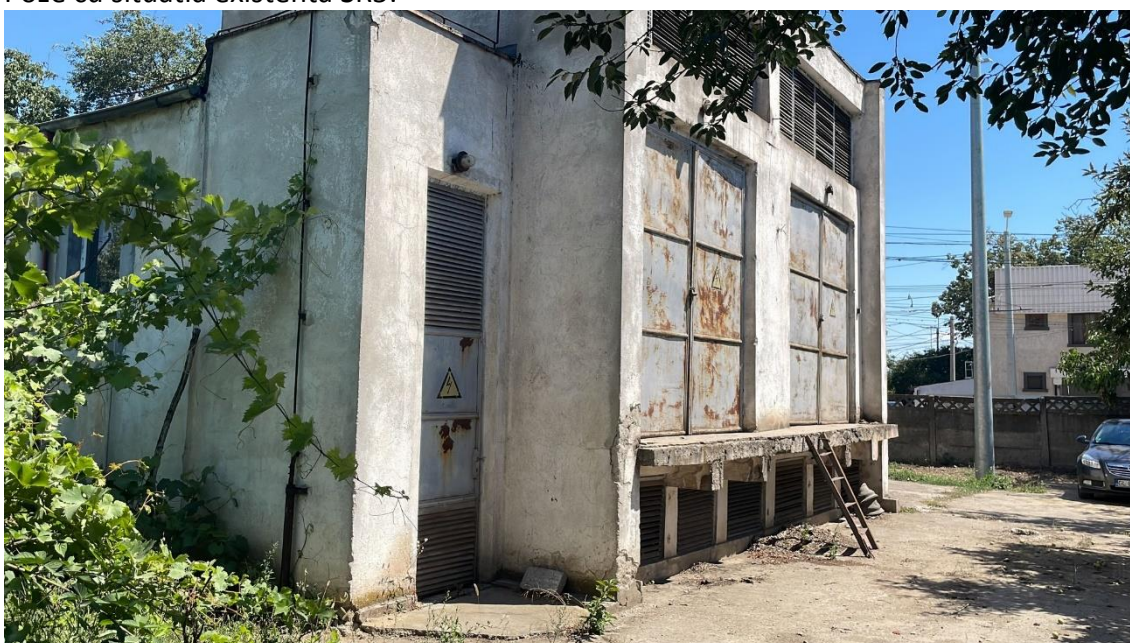
Poze cu situatia existenta SR5:
