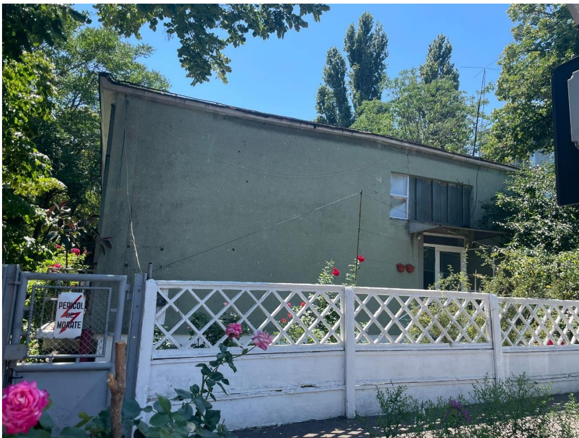
Poze cu situatia existenta SR1:
