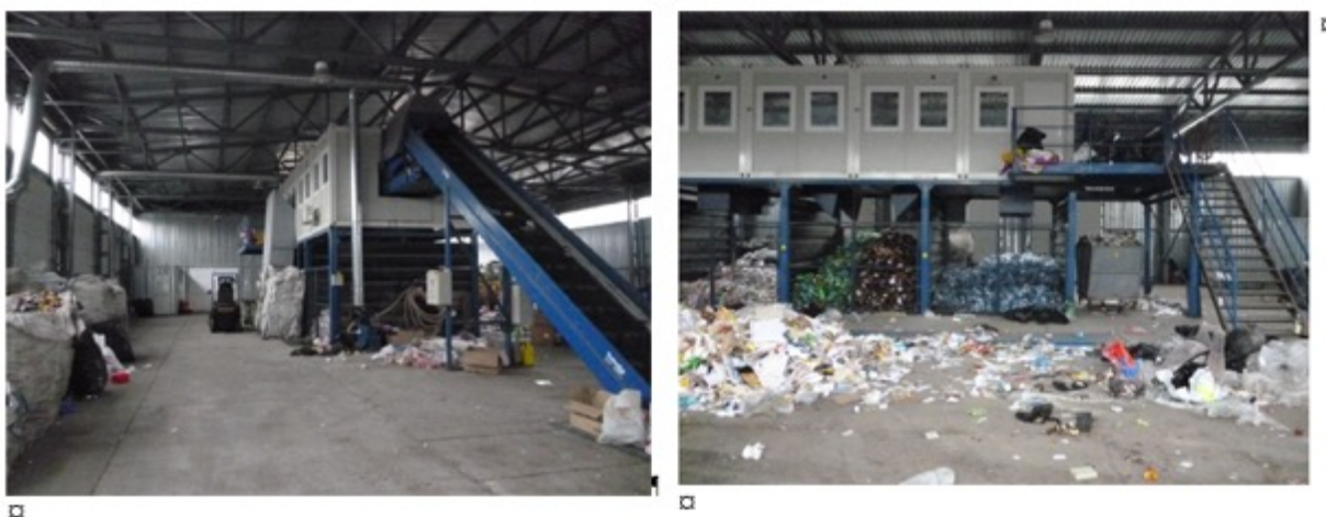
Figura 4-5: Stația de sortare Galați
