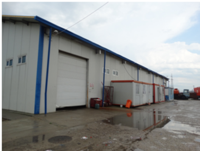
Figura 4-6: Imagine stației de sortare Tecuci
