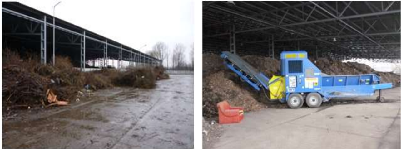
Figura 3-12: Stația de compostare Galați
