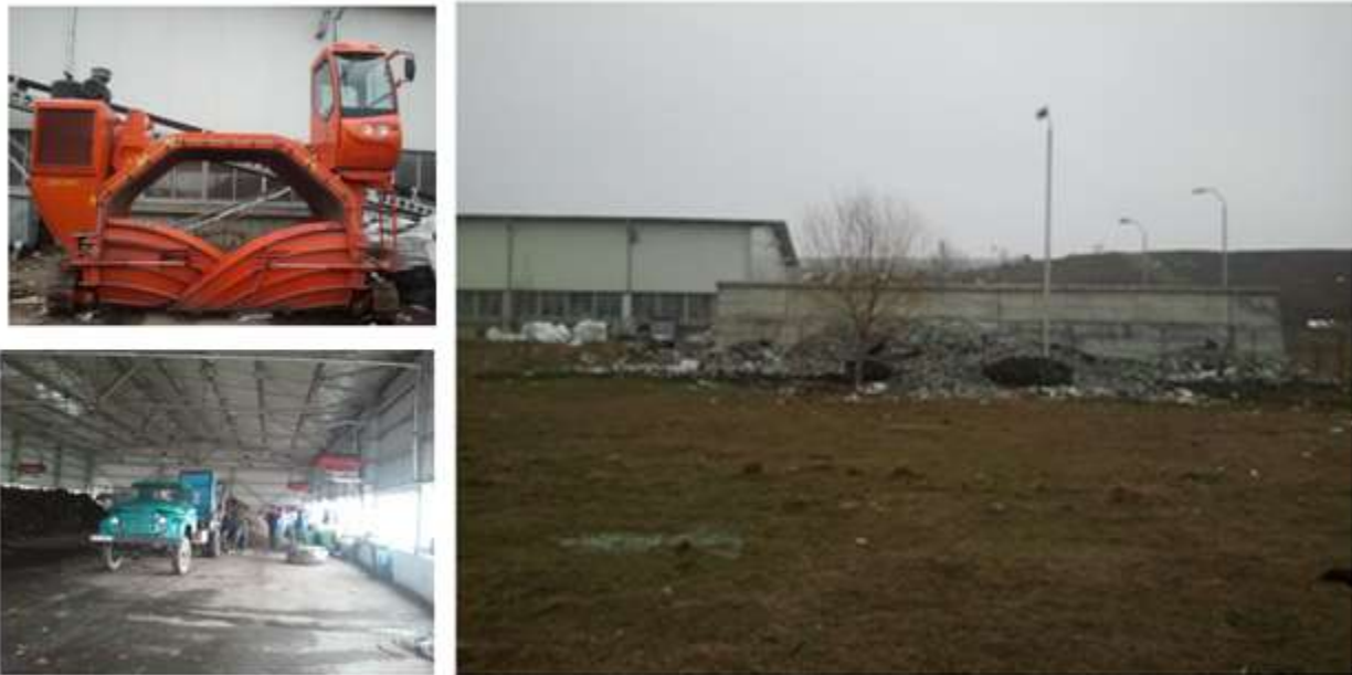
Figura 3-13: Poze stația de compostare Tg. Bujor
