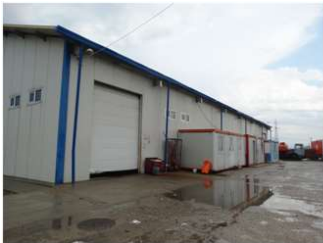
Figura 3-10: Imagine stației de sortare Tecuci
