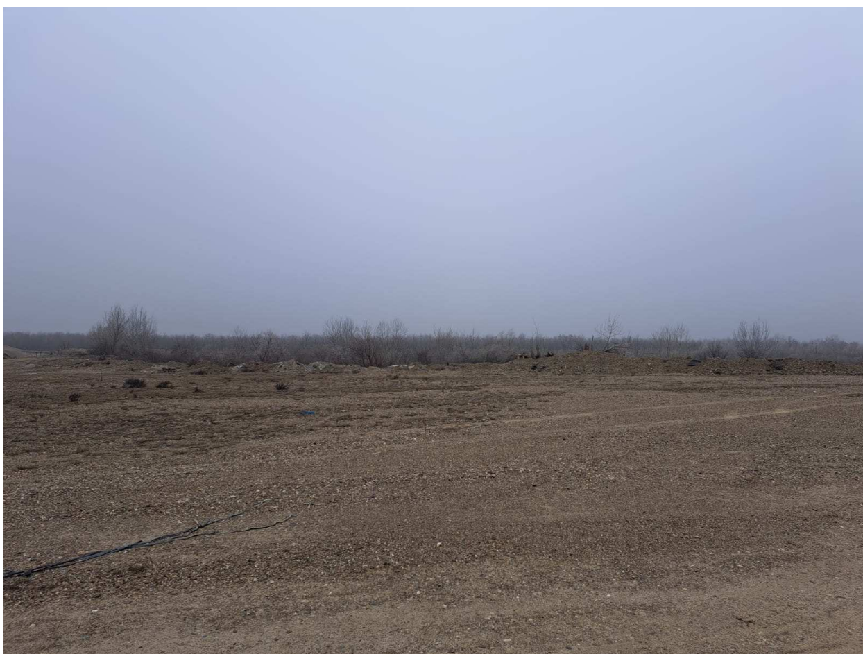
Figura nr. 20. Vedere de ansamblu asupra amplasamentului analizat
