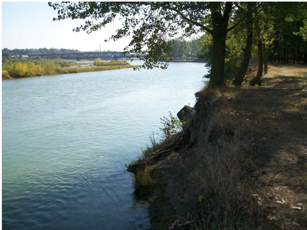
Ob. 1.2 Cosmești Vale - Zona 2 - vedere înspre aval
