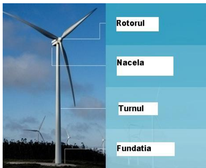
Figura 3. Componentele principale ale turbinei
