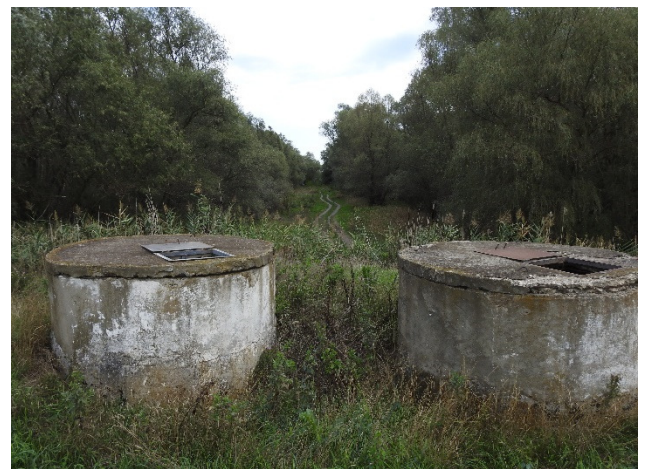
Figura nr. 75: SPA Prut (stânga) și caminele de vane din zona dig – mal - lunca râului Prut (dreapta)
