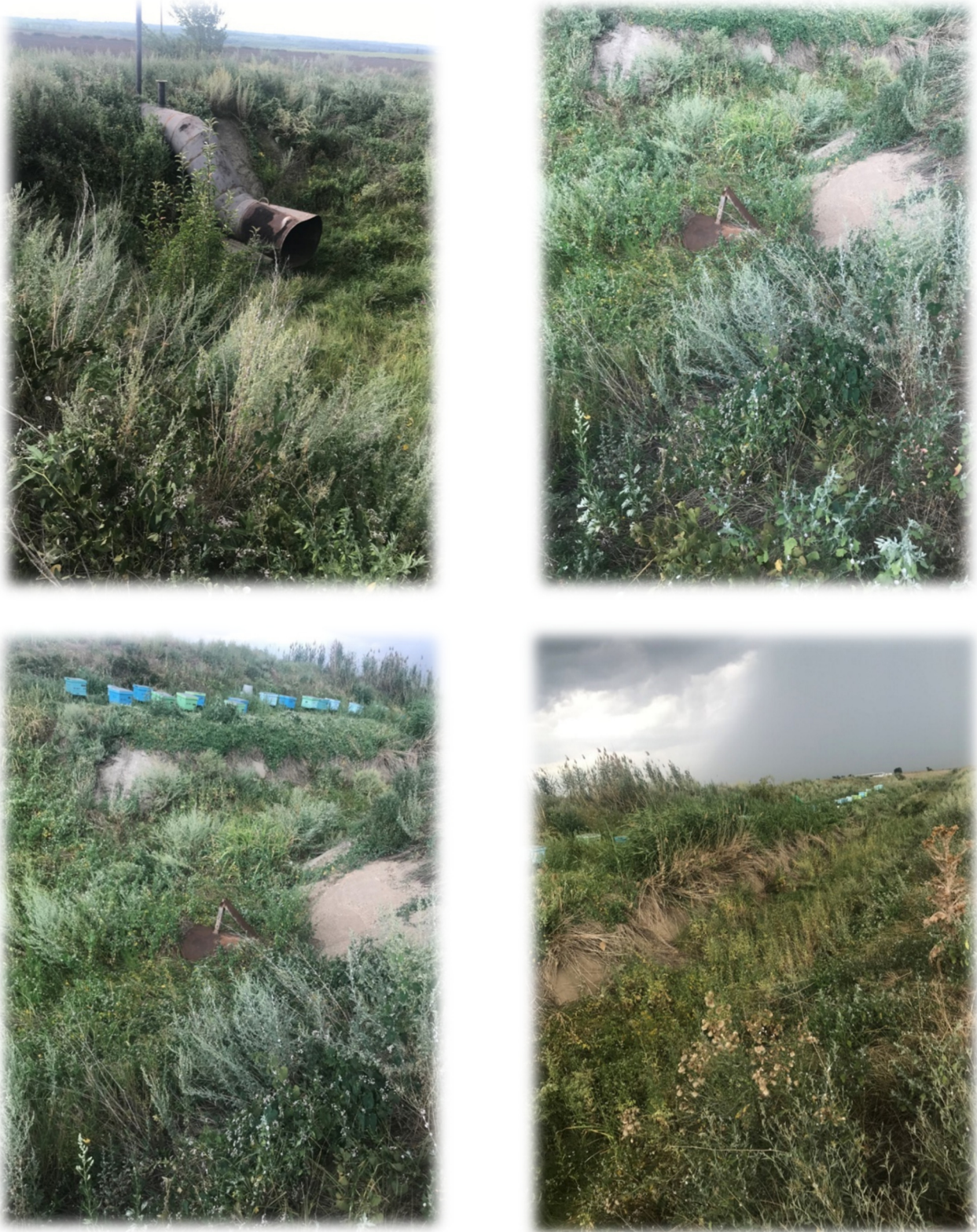
Figura nr. 5: Foto de pe amplasamentul existent – Canalul de aducțiune CA Barboși
