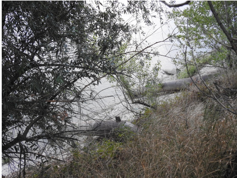
Figura nr. 34: Conduțe de aspirație SPA Barboși
