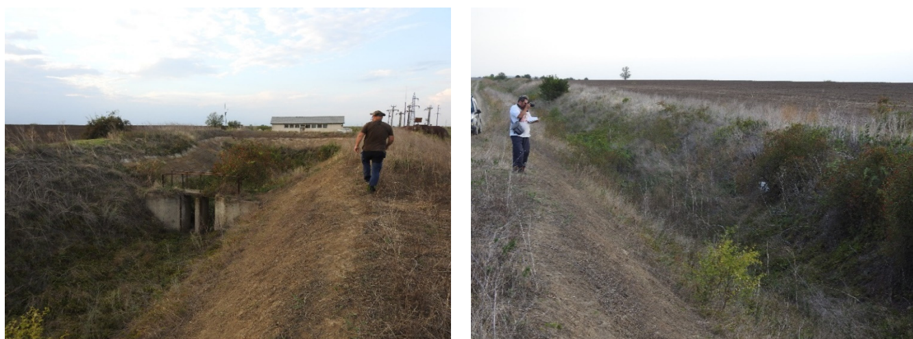
Figura nr. 42: Aspectul canalului în sectorul din amonte
