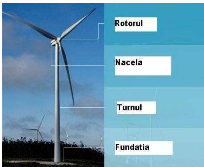
Figură 4 . Componentele principale ale turbinei
