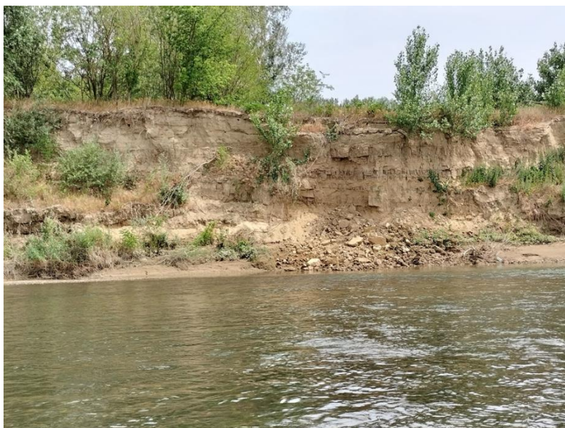
Figura 52 Detaliu eroziune mal drept
