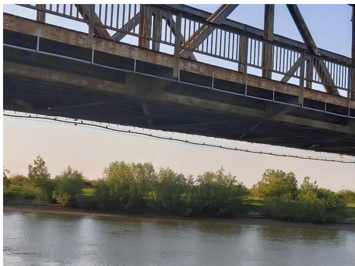
Vedere spre mal stang – amonte pod
