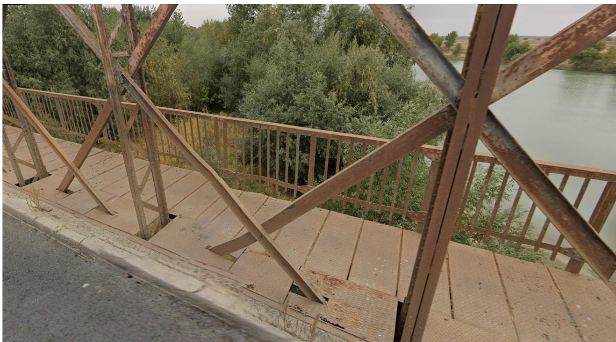
Figura nr. 3 - Vedere de pe pod, zona mal stang rau Siret
