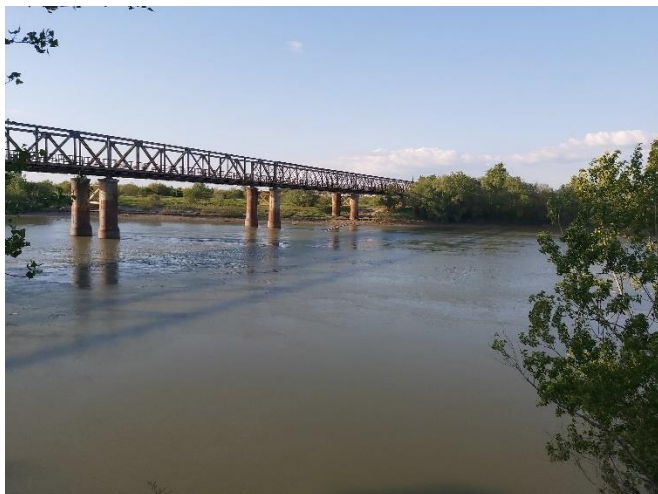
Zona aval pod – vedere spre malul stang
