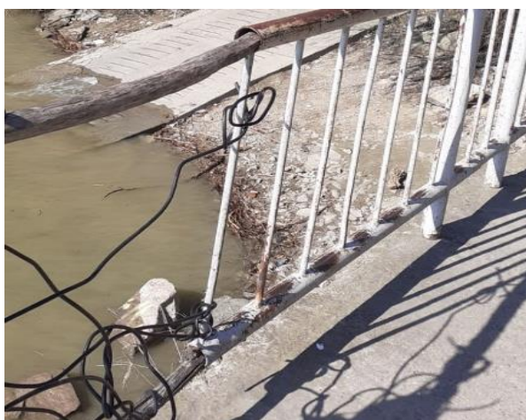
Balustrada podețului pietonal
