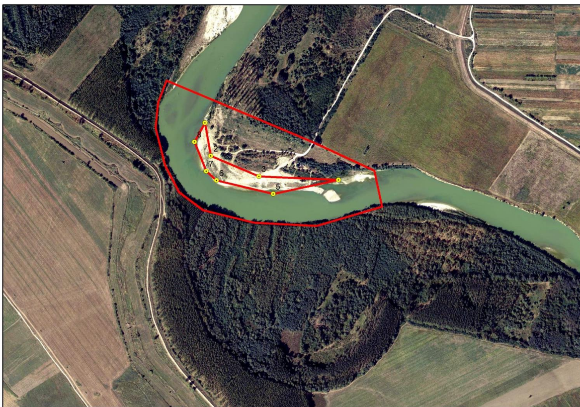
Figura 2 Detaliu amplasament propus pentru decolmatare
