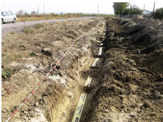
Foto 5 Sant pentru conducta de amestec
