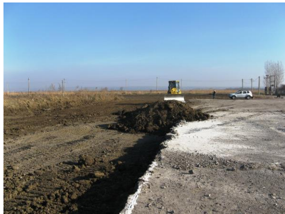
Foto 8 Restrangere careu de exploatare
