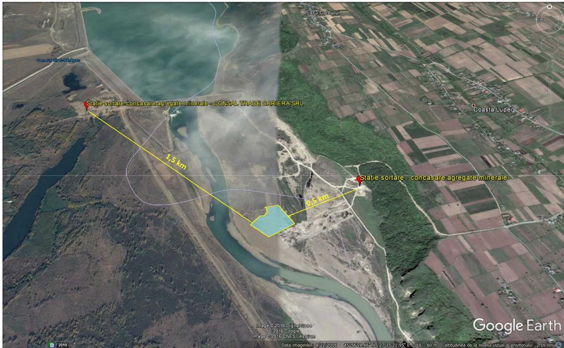
Figura nr. 3. Localizarea perimetrului de exploatare în raport cu stațiile de sortare-concasare agregate minerale din zonă (Sursa: Google Earth)
