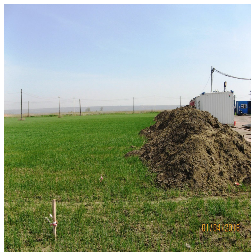
Foto 4 Organizare de santier
