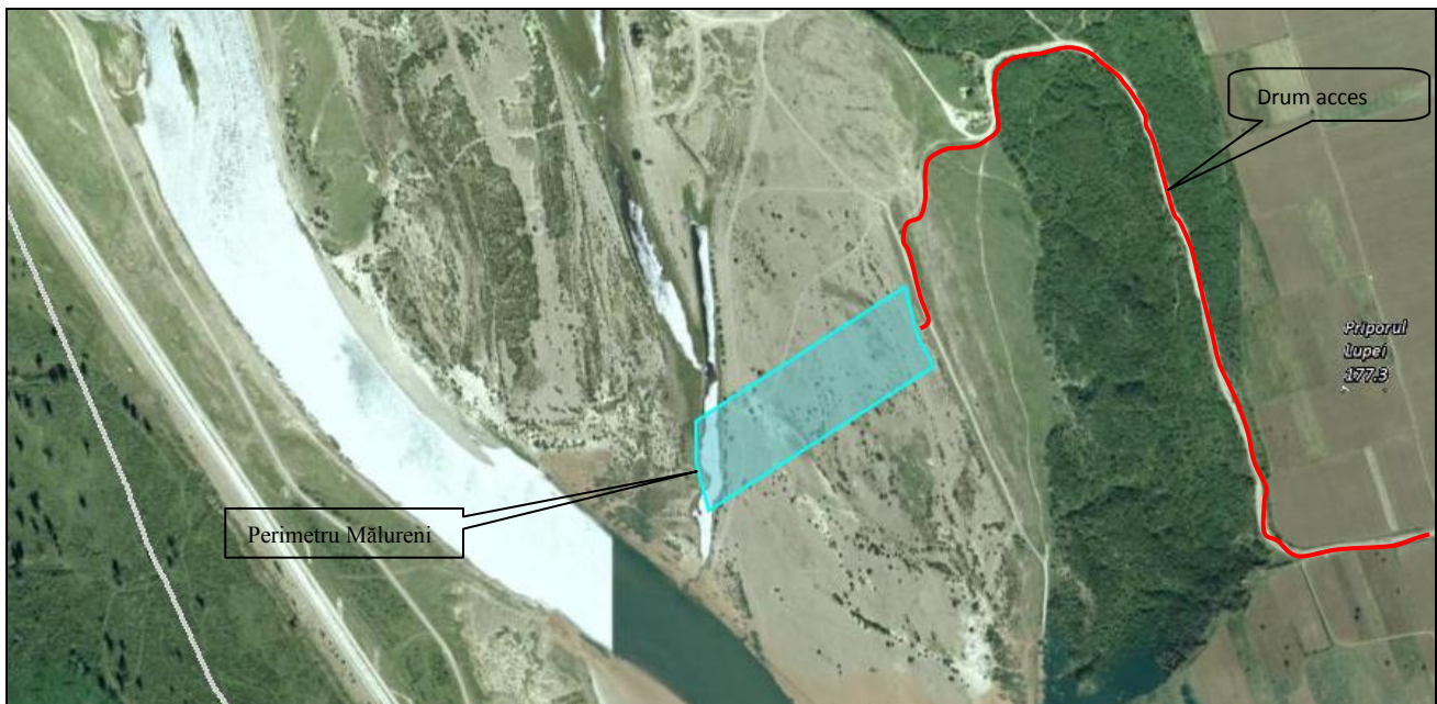
Fig. 2 Acces la perimetrul – drum de exploatare în detaliu
