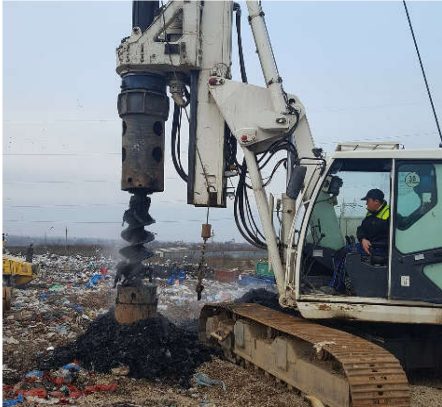
Montare puturi pentru sistemul de extractie a biogazului
